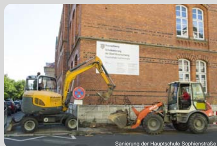
Sanierung der Hauptschule Sophienstraße
